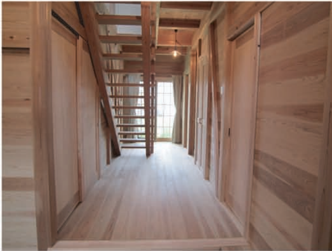
『板倉づくりの家』 柱と柱の間に3センチの板を落とし込む、 昔ながらの工法です。板の持つ独特の粘りで、 地震の横揺れを吸収する減衰工法。
